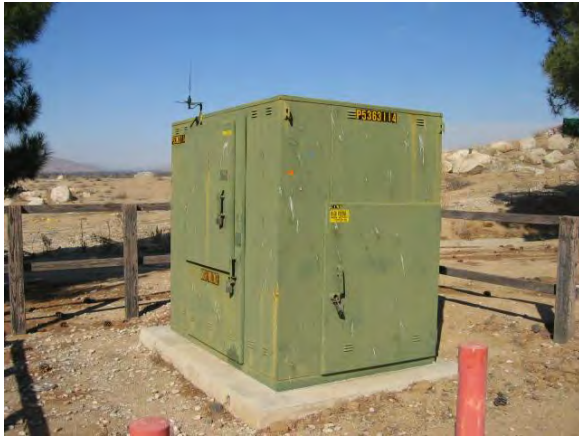
SCE High Voltage Switch
