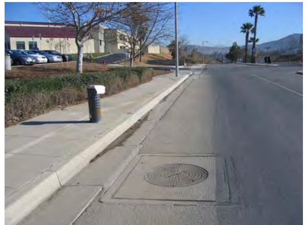
SCE Manhole on 3 rd Street
