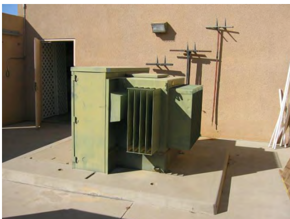
SCE HV Switch w/ Meter Antenna
